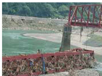
【橋梁の被害】球磨川の増水、濁流で落橋した深水橋、坂本橋、鎌瀬橋及び第一橋梁（JR）
