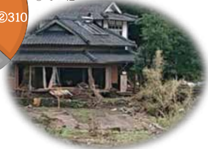
濁流にのみ込まれた住宅
