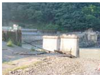
【橋梁の被害】球磨川の増水、濁流で落橋した深水橋、坂本橋、鎌瀬橋及び第一橋梁（JR）
