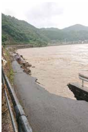
【道路の被害】道路上層部が浸しよく等された国道219号、道路が決壊した県道中津道八代線
