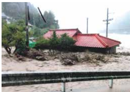
球磨川からの濁流、土砂流入で孤立する 三坂自治公民館
