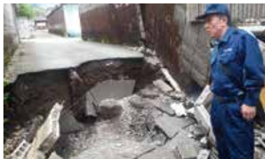
道路が激しく損傷した阿蘇市(4月26日)
