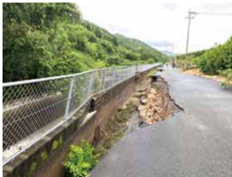
豪雨で被災した遙拝頭首工(3月)と不知火幹線(6月)
