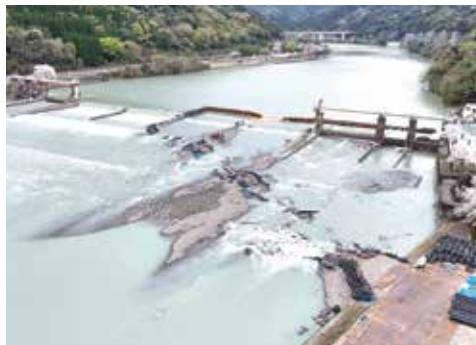
豪雨で被災した遙拝頭首工(3月)と不知火幹線(6月)
