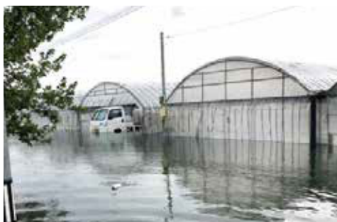
地面から約60センチの高さまで浸水し苗・機械も被害を受けたハウス
