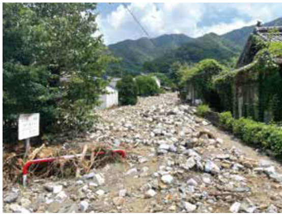
龍峰山の斜面崩壊で生活道路・水路を土石流に覆いつくされた興善寺町
