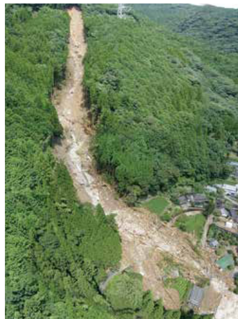
山腹崩壊により民家を押し潰す（泉町下岳古屋敷）
